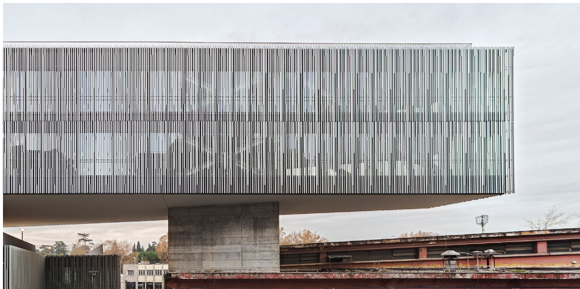
La Città del Sole (« Cité du soleil ») à Rome, du bureau d'architectes Labics, est un complexe polyvalent mêlant fonctions publiques et privées. Tant la façade constituée de profils en aluminium que les lamelles vitrées translucides des différents bâtiments protègent les occupants du soleil et les oiseaux des collisions.
