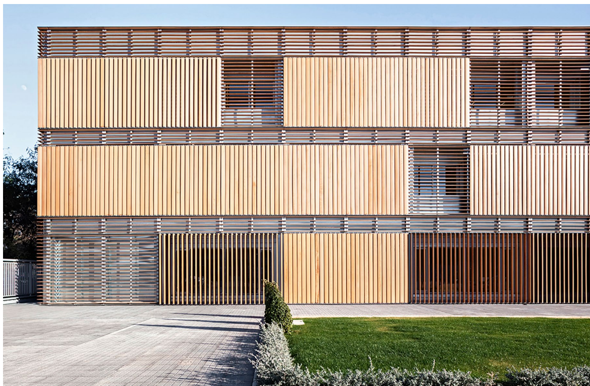
Bloc ouest du Centre de langues de l'Université de Valence, en Espagne, conçu par le bureau d'architectes Arkitera SLP. La structure de la façade est caractérisée par une combinaison de lamelles de protection solaire fixes et mobiles.
