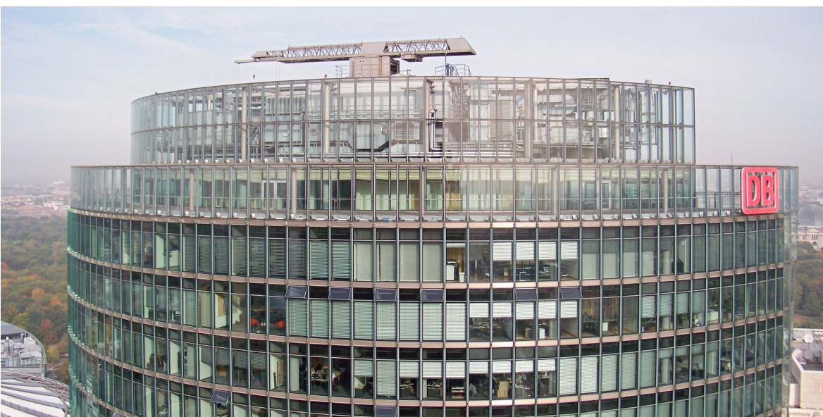
Attique vitrée de plusieurs mètres de haut sur une tour : les oiseaux ne heurtent pas seulement les parois extérieures, mais entrent aussi en collision depuis l'intérieur une fois entrés dans l'espace librement accessible.
