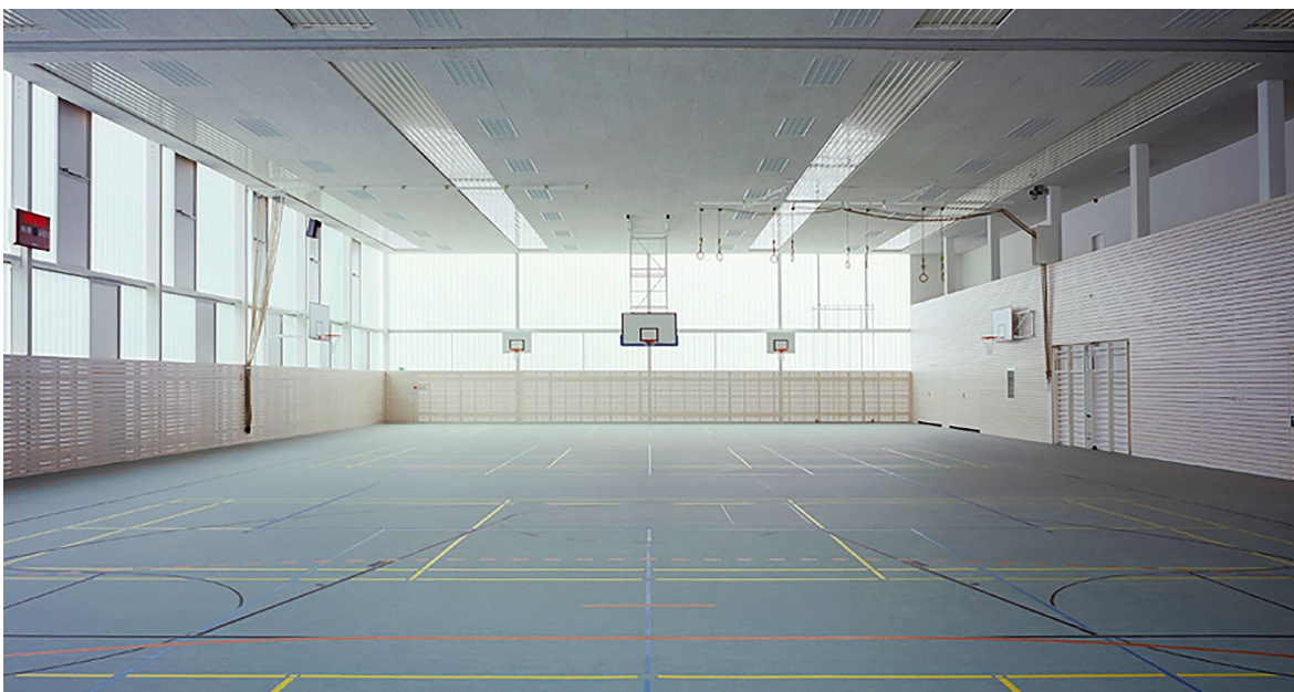
L'enveloppe du bâtiment de la salle de sports d'Ingolstadt (Allemagne), conçue par von Fink+Jocher, est constituée d'une structure de verre profilé, doté entre ses deux couches d'une isolation thermique translucide. Elle apporte une lumière suffisante, sans pour autant former des ombres gênantes sur la surface de la salle de sports.
