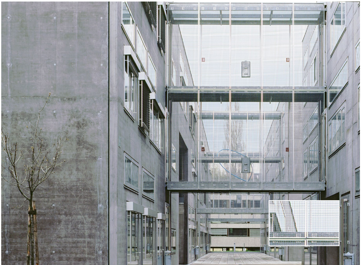
Les différentes unités architecturales de la partie moderne de la Technische Universität de Graz (Autriche), conçues par le bureau d'architectes Riegler Riewe, sont connectées entre elles par des ponts à plusieurs étages. Les éléments de façades, des grilles d'acier, laissent passer la lumière et permettent de voir, tout en étant bien identifiables par les oiseaux comme des obstacles.
