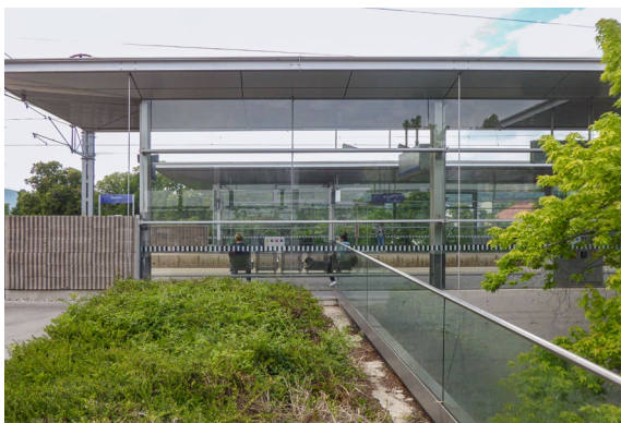
Dans une zone végétalisée, les constructions en verre sont particulièrement dangereuses pour les oiseaux – à l'exemple de cet accès de gare.
