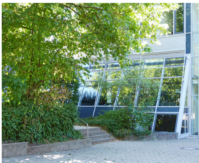
Les reflets de la façade vitrée inclinée de cette école sont aussi clairs que si la paroi était verticale, et présentent donc un risque élevé de collision.
