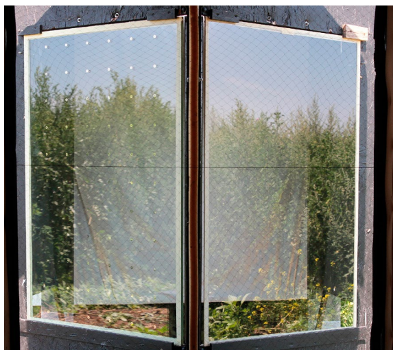
Eastman Saflex® FlySafe™ SEEN shiny 9/90 : points métallisés de 9 mm de diamètre, espacés de 90 mm : hautement efficace, et également adapté en position 2 en raison du facteur de réflexion élevé.
