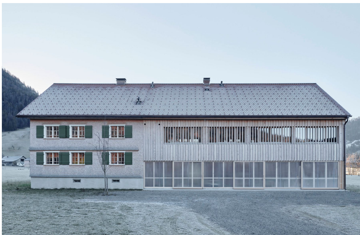
A l'occasion d'une réaffectation, les architectes du bureau gruber locher ont profité de l'assainissement de la maison Grossenbündt à Hittisau (Autriche), classée, pour abriter les locaux d'exploitation derrière un espace semi-transparent. La structure de la façade en bois traditionnelle a été prolongée par-dessus la longue rangée de fenêtres à l'étage supérieur, pour protéger du soleil, tandis que les fenêtres classiques de la partie habitation ont été conservées. Les oiseaux peuvent identifier sans problème ces matériaux et ces structures.
