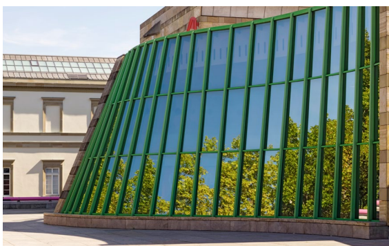
Le verre, avec sa surface lisse, est toujours réfléchissant lorsque l'arrière est moins éclairé que l'avant. Des revêtements supplémentaires de la façade vitrée peuvent accentuer les contrastes de réflexion. Pour les oiseaux, les arbres reflétés, mais aussi le ciel, sont perçus comme de l'espace libre.
