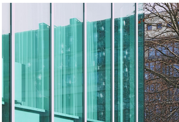
Les traces de collision montrent clairement que le verre teinté n'offre aucune protection contre les chocs.
