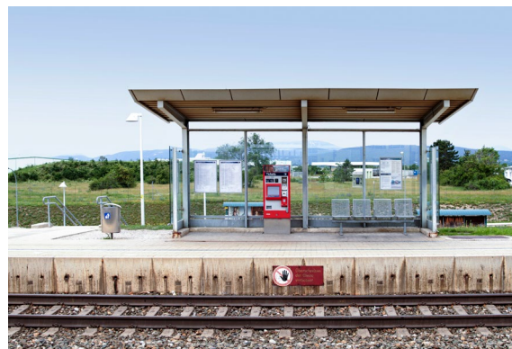
Les abris de transports publics sont très souvent conçus en verre, sans que l'on ne pense à des mesures de sécurité pour les oiseaux.
