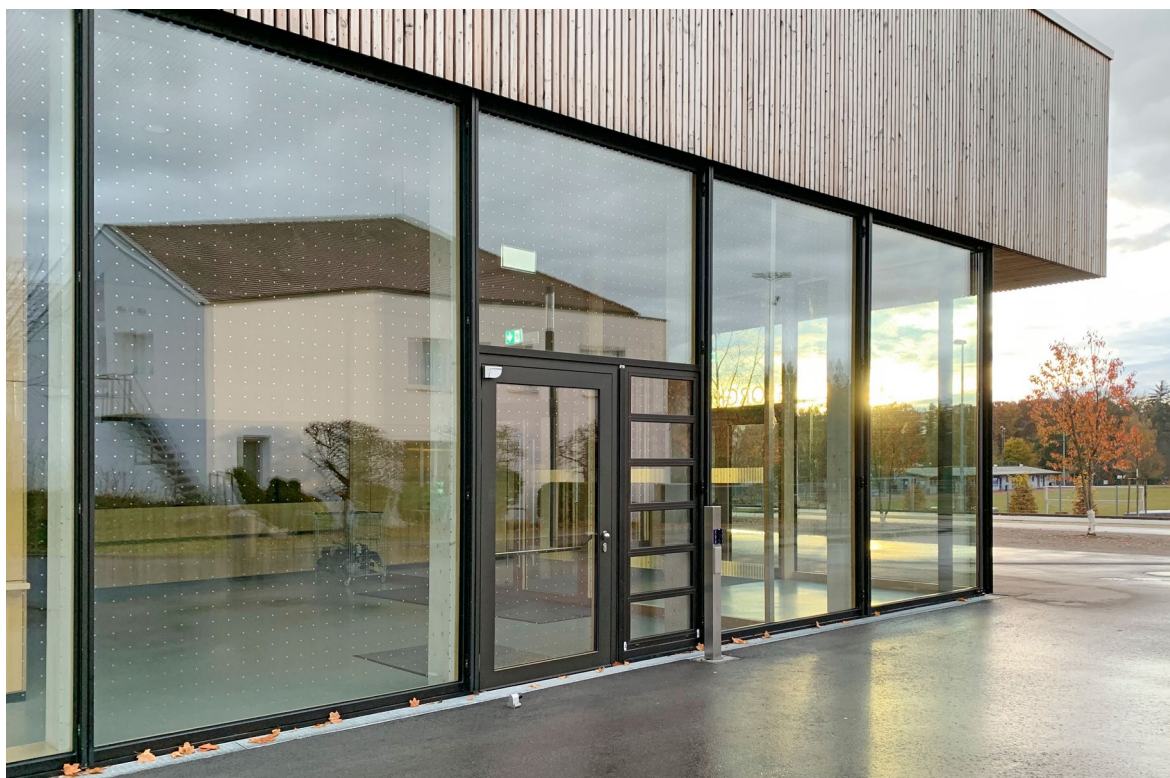
Ce motif constitué de points très métallisés de 9 mm de diamètre, espacés de 90 mm, est laminé à l'intérieur d'une vitre isolante et pourtant hautement efficace. Jusqu'à présent, les marquages noirs ne fonctionnent que s'ils sont posés à l'extérieur des façades vitrées, à cause des reflets.
